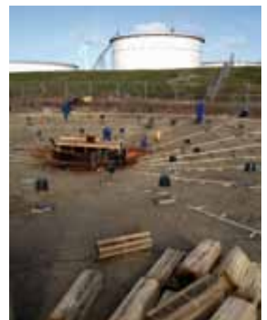
We kijken voortdurend naar manieren om onze multidisciplinaire kennis op het gebied van water in te zetten voor industriële opdrachtgevers. In 2012 hebben we opdracht verkregen voor de bouw van een nieuwe waterzuiveringsinstallatie voor BP Raffinaderij in Rotterdam. De nieuwe installatie is gebaseerd op een actief slijbproces en zal in 2014 operationeel zijn.
