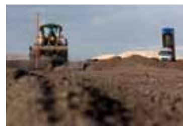
De A50 tussen Ewijk en Valburg wordt verbreed en de knooppunten worden ingrijpend gewijzigd. Bij het knooppunt Ewijk komt een compleet nieuwe afslag van Den Bosch naar Nijmegen waarvoor veel zand nodig is. Zand is duur, schaars en eindig als grondstof. Daarom is er gekozen voor AEC-bodemas, een secundaire grondstof, gemaakt uit verbrand huisvuil.
