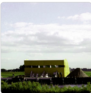
Gemaal Schagerkogge Het gemaal past in het beschermde dorpsgezicht.
