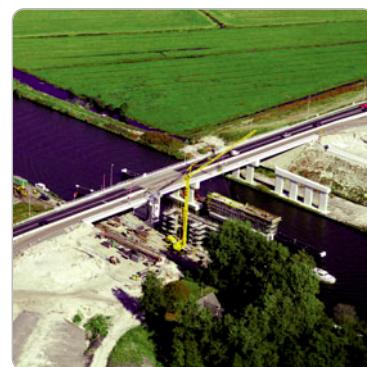
Fonejachtbrug N31 Onder de op- en afritten liggen AVI-bodemassen.
