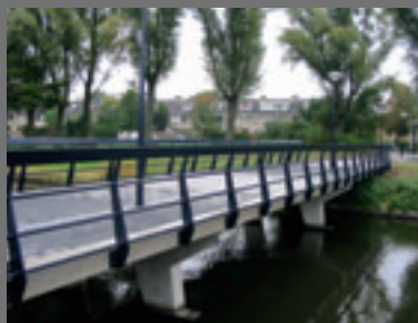
Fiets- en voetgangersbruggen verbeteren de bereikbaarheid van de Zuidtangent in Hoofddorp.
