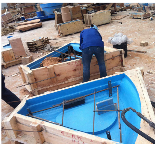
Het maken van de mal voor het kabel wiel
