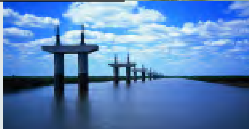
Baggerwerk Rosario, Argentinië
