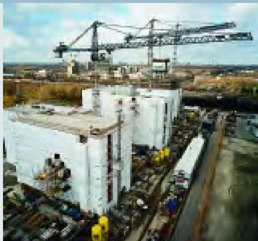
Hoofdkantoor Ballast Nedam in aanbouw, Nieuwegein
