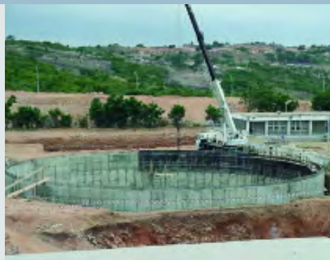
Waterzuiveringsinstallatie Accra, Ghana
