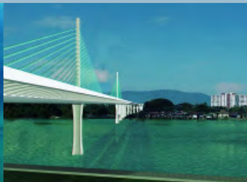
Sunga Perai tuibrug, Butterworth, Maleisië
