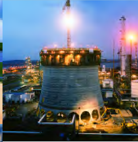
Koeltoren Dow Benelux, Terneuzen
