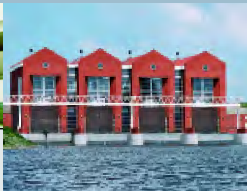
Gemaal Rozema, Termunterzijl
